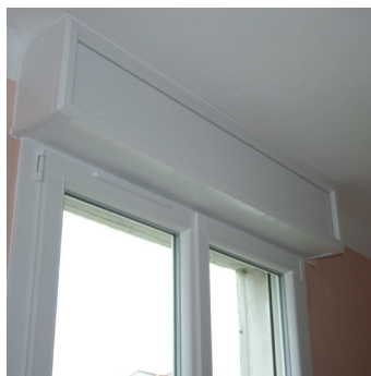
Pose des joues et joints d'étanchéité
