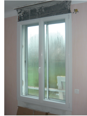
Pose de la nouvelle fenêtre PVC
