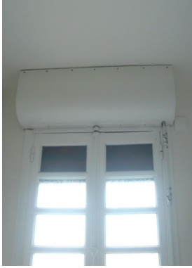
Volet roulant et fenêtre avant rénovation
